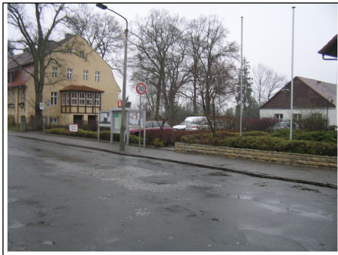
Abb.6: nördlich an das Plangebiet angrenzendes Wohngebäude an der Lindenstraße (ehem. Försterei, denkmalgeschützt), rechts im Bild der heutige Jugendklub
