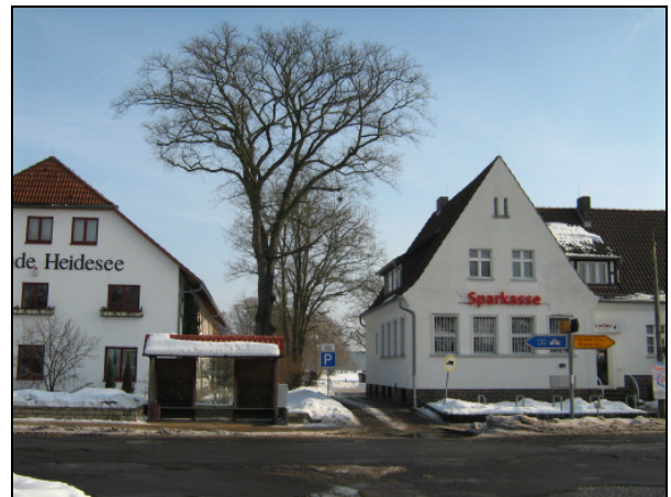
Abb.: zum Abriss geplante Sparkasse
