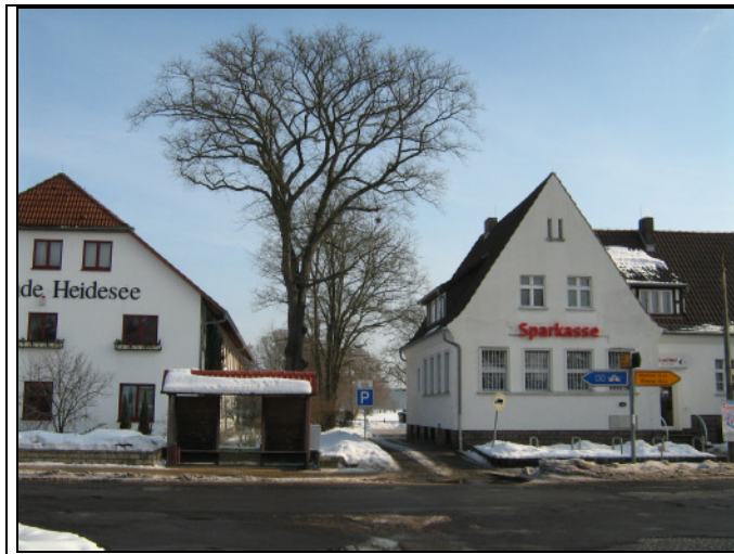
Abb.3: Straßenansicht der bestehenden Hauptgebäude
