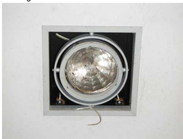
**Abb. 21:** Lampeneinfassung mit Zugang zum Hohlraum
