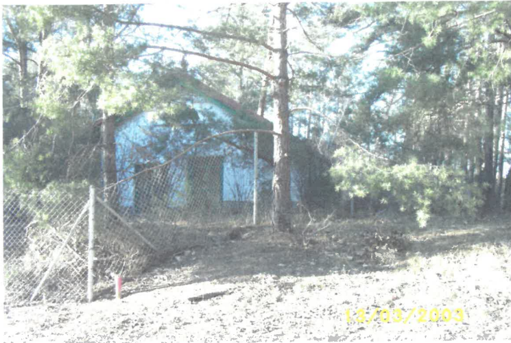
Abb.1 Annähernd fertiggestelltes Gebäude auf dem Flurstück 114 (Aufnahme aus südl. Richtung)
