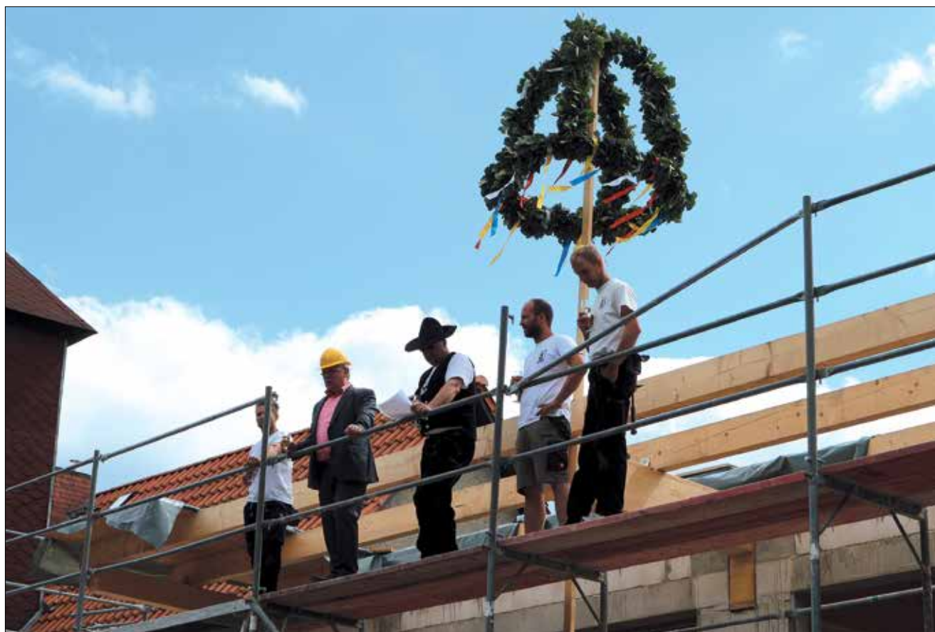
Am 13.07.2017 wurde gemeinsam mit dem Bürgermeister, den am Bau Beteiligten, Mitgliedern der freiwilligen Feuerwehr und des Feuerwehrvereins sowie Gemeindevertretern das Richtfest für das neue Feuerwehrgebäude im OT Prieros gefeiert.
